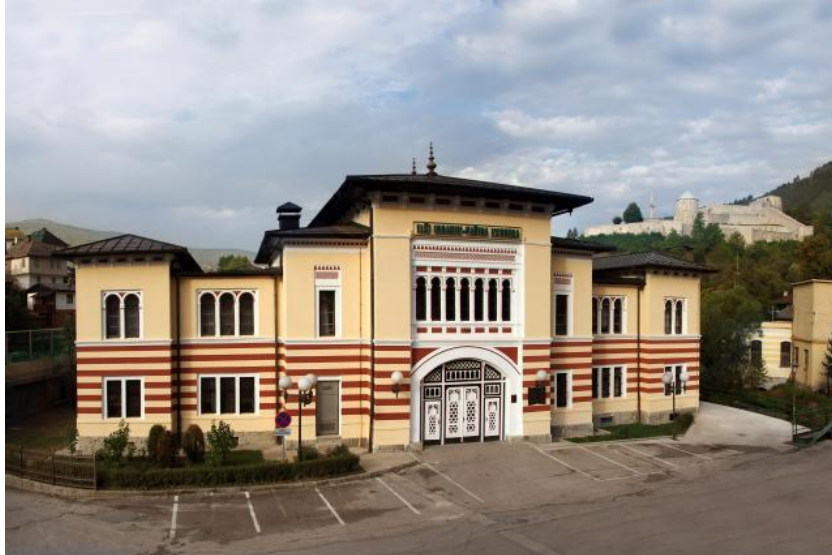
(sl. 15 b.) Pročelje Elči hadži Ibrahim- pašine Medrese danas
