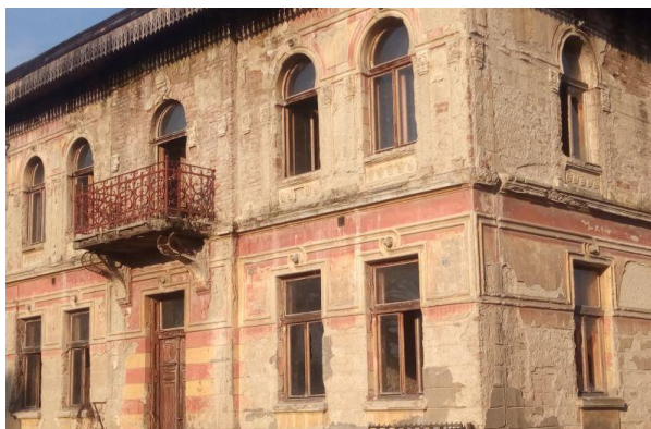
(sl. 3.) Kočića kuća u Brčkom (1907. g)
